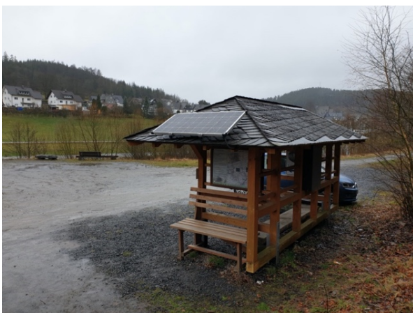
Abbildung 6: Montage des Panels in Südausrichtung (Quelle: eigene Fotografie)
